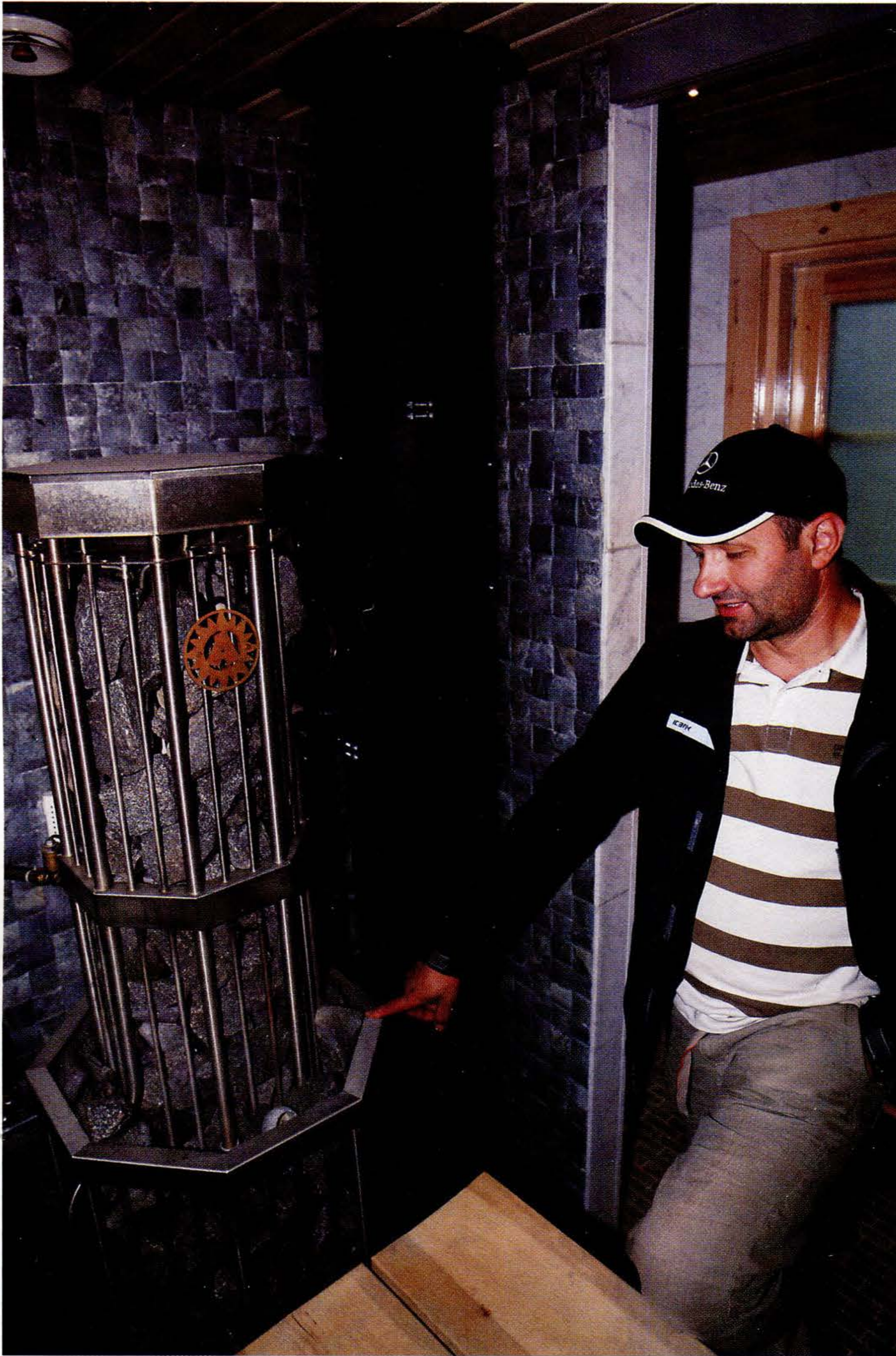
Nicolae Castaian on tyytyväinen talteenottopiipun ja kiukaan yhteistoimintaan. Vesi lämpenee kuumien savukaasujen vaikutuksesta piipussa.
