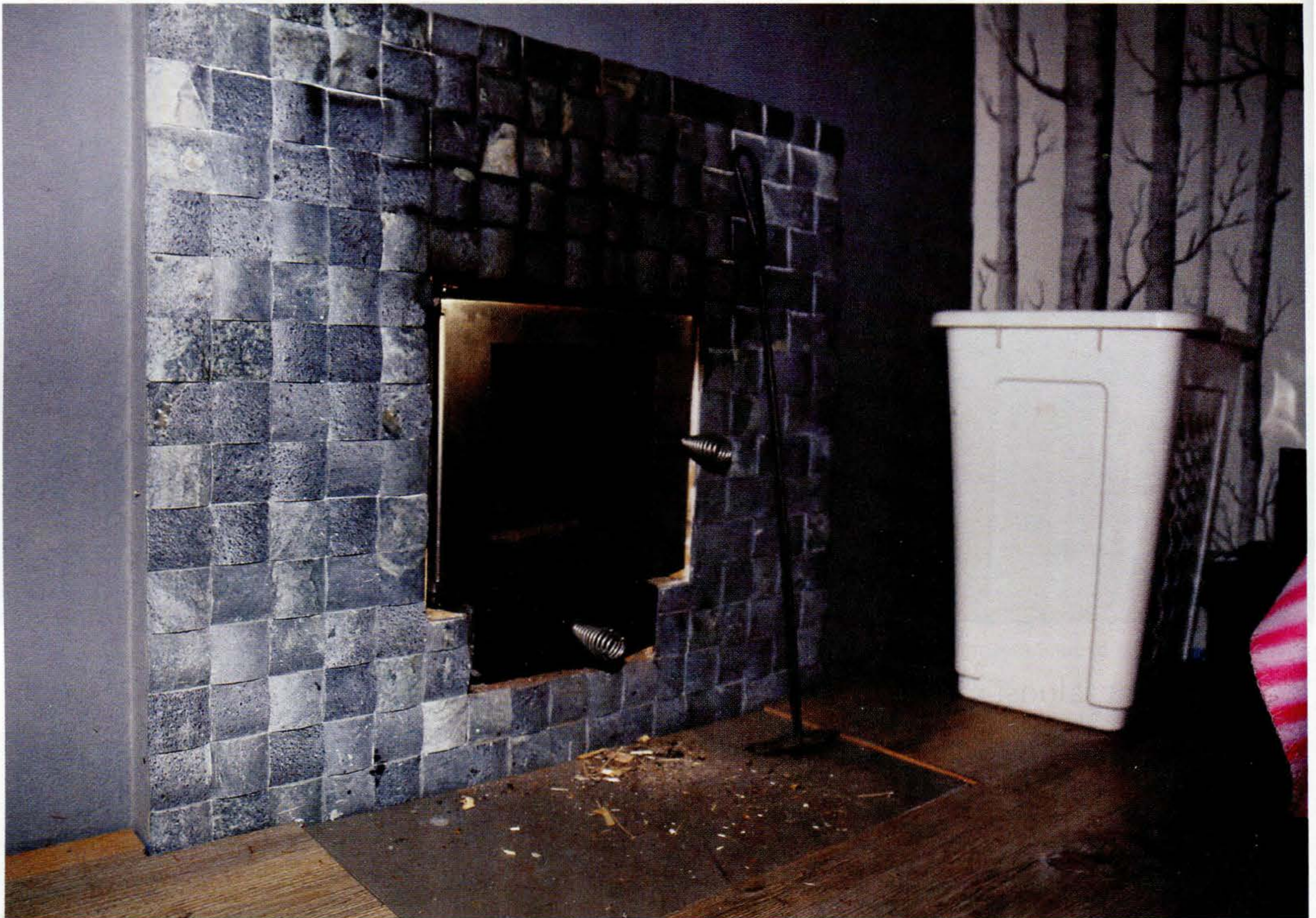
Kiuas lämmitetään pukuhuoneen puolelta, jolloin se on myös takka.
